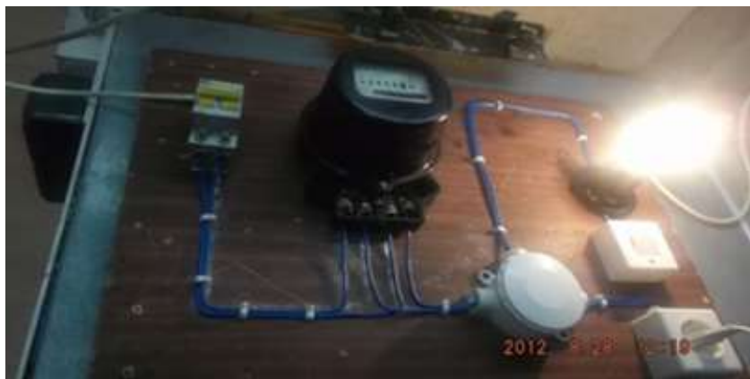
Инструкционная карта 1. Разметка трасс электропроводок
