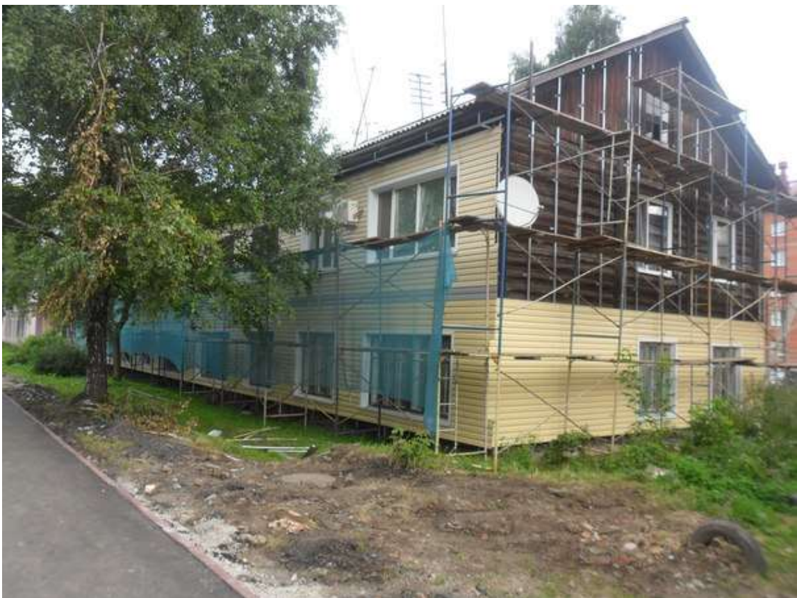
Реконструкция улицы Ленина.
