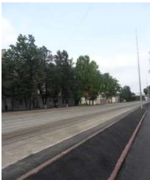
Ремонт дороги по ул. Ленина.
