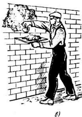
Рис. 1 Набрасывание раствора штукатурной лопаткой на стены
