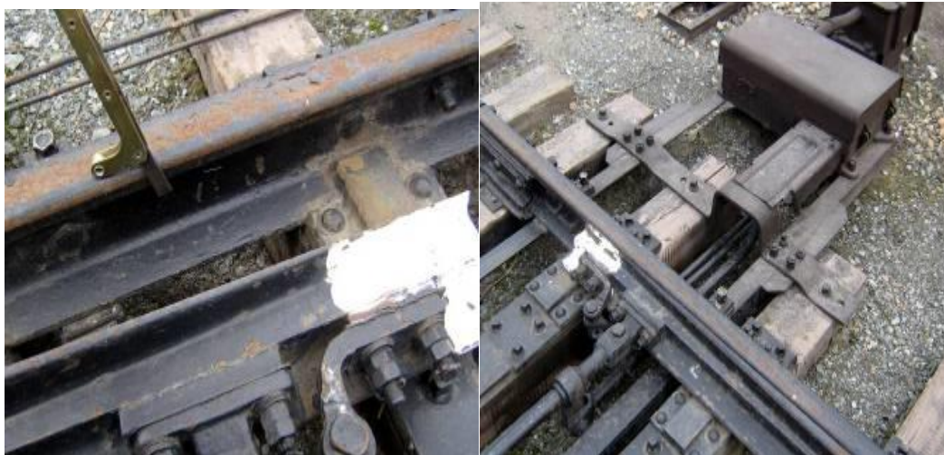
Рисунок 13 – закладка щупа 4мм
